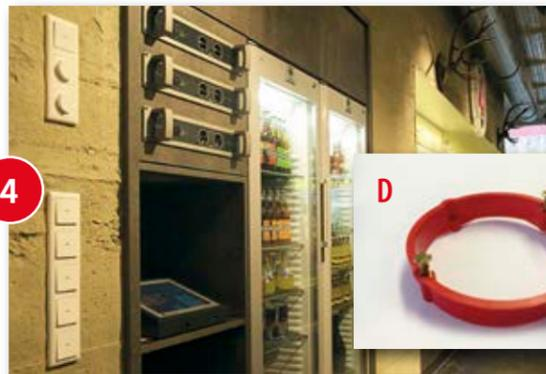
**4. Die aufgesetzte Schaltermontage** bedarf eines Distanzringes (über den Elektro-Fachhandel zu beziehen) (Abb. D). Damit wird die Plattenstärke ausgeglichen. Die Schalterabdeckung wird abgeklebt und mit Spachtel unterfüttert oder aber die Steckdose wird eckig ausgeschnitten und angespachtelt. In diesem Fall werden keine Distanzringe benötigt.
