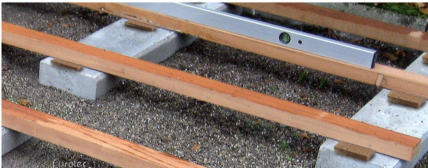
Die Kork-Pad Abstandhalter werden zwischen die Terrassenunterkonstruktion und das Fundament/den Untergrund gelegt und bilden so einen Abstand, der dem konstruktiven Holzschutz dient. Die Kork-Pad Abstandhalter stehen in drei verschiedenen Stärken zur Verfügung (3, 6 und 10 mm). Nützliche Nebeneffekte sind, neben den genannten Vorteilen, dass durch den Einsatz der Abstandhalter eine Höhennivellierung der Unterkonstruktion möglich ist und die Lasten gleichmäßig verteilt werden.
