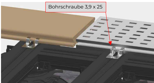
Bild 24. Danach werden die Distanz-Clips auf die WPC-Diele und das Drainageprofil geschoben und mit den Bohrschrauben 3,9 x 25 mm auf der Aluminium-Unterkonstruktion geschraubt.
