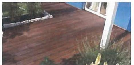
Bei ausgelagten Holzdecks kann ein zweiter Anstrich erforderlich sein. Diesen zweiten Anstrich ebenfalls dünn in Holzmaserichtung auftragen und wiederum mindestens 8 Stunden trocknen lassen (staubtrocken nach ca. 4 Stunden).
