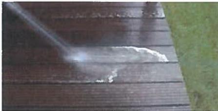
Im nächsten Schritt spülen Sie die behandelte Fläche gut ab. Dabei ist darauf zu achten, dass alle Entgrauerreste gründlich entfernt werden. Das geschieht am Besten mit einem Spritzschlauch und einem Schrubber. Schon jetzt erhalten Sie einen Eindruck davon, wie Ihre «neue» Terrasse aussehen wird.
