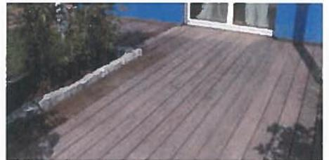
Die entgraute Fläche trocknet wie eine normale Oberfläche. Deshalb empfiehlt es sich, die Entgrauung und Ölpflege bei guter, trockener Witterung vorzunehmen. Einen eventuell nachfolgenden Anstrich der Holzflächen mit SAICOS HOLZ-SPEZIALÖL ist erst nach vollkommener Trocknung möglich.
