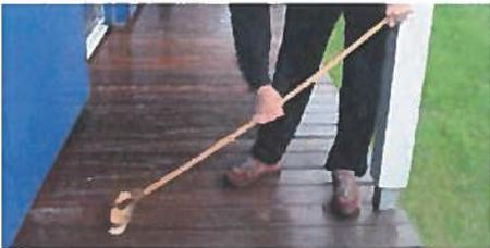
Nach dem rund halbstündigen Einwirken des SAICOS HOLZ-ENTGRAUERS bearbeiten Sie jetzt die Oberfläche intensiv mit einem Schrubber oder einer Bürste und unter Einsatz von viel Wasser. Falls Sie eine elektrische Bodenbearbeitungsbürste für den Nassbetrieb zur Verfügung haben, können Sie diese idealerweise auch einsetzen. Während des Bürstens ist deutlich erkennbar, wie die erfolgreich behandelten Flächen heller werden. Falls noch vergraute Stellen vorhanden sind, Vorgang wiederholen.
