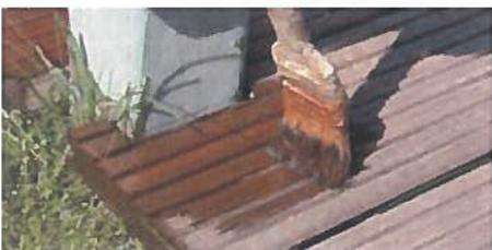
SAICOS HOLZ-SPEZIALÖL ist ein transparenter, offenerporiger Holz-Spezialanstrich auf der Basis natürlicher, pflanzlicher Öle. Speziell entwickelt für den Schutz und die Pflege von Holzdecks. Die seidenmatte, natürlich wirkende Oberfläche betont Holzton und Maserung des Holzes. Der Anstrich verbindet sich dauerhaft mit dem Holz, blättert und schuppt nicht ab. Er reduziert Quellen und Schwinden des Holzes, hat ein besonders hohes Eindringvermögen und ist extrem witterungsbeständig.
