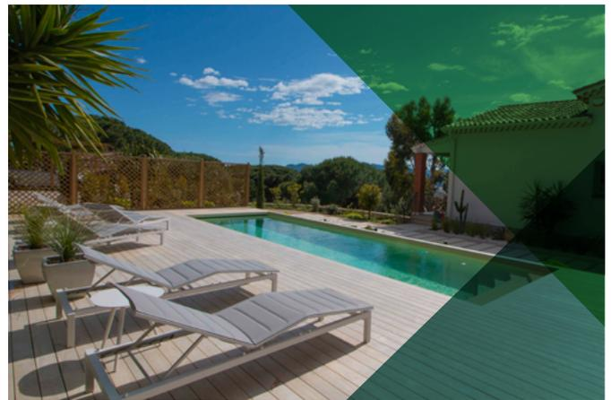
Auf horizontalen Außenflächen bildet sich mit der Zeit ein Biofilm, der Wasser hält und die Trocknungsgeschwindigkeit der Dielen reduziert. Ein großer Aufbau eines solchen Biofilms sollte verhindert werden. Neben einer fachgerechten Konstruktion sollte eine regelmäßige Reinigung in Betracht gezogen werden, um die Bildung eines solchen Biofilms zu kontrollieren.
