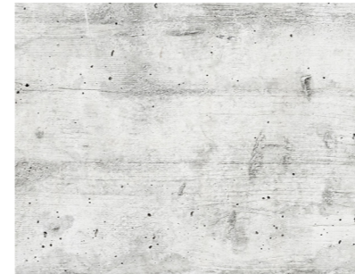
Agune Sichtbeton F001
