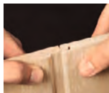
Nut-Feder-Paneel mit sichtbarer Feder
