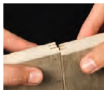
Nut-Nut-Paneel mit Versatzfuge
